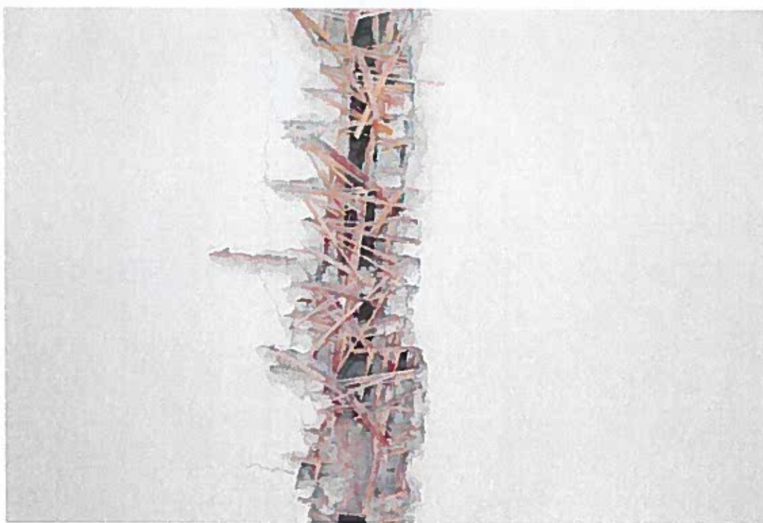
Foto. 8 Místnost A.N04.011, detail odstraněné části podhledu po vybourání příčky. Rákosové rohože jsou zde připevněny v obou směrech.
