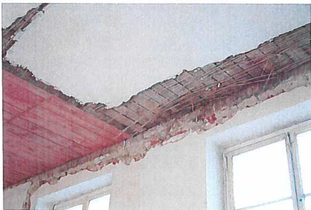
Foto. 23 Místnost B1.N03.011-012, rákosové rohože jsou v této budově staré 108 let, jsou velmi řídké a seschlé. Jejich zachování se jeví jako anachronismus.
