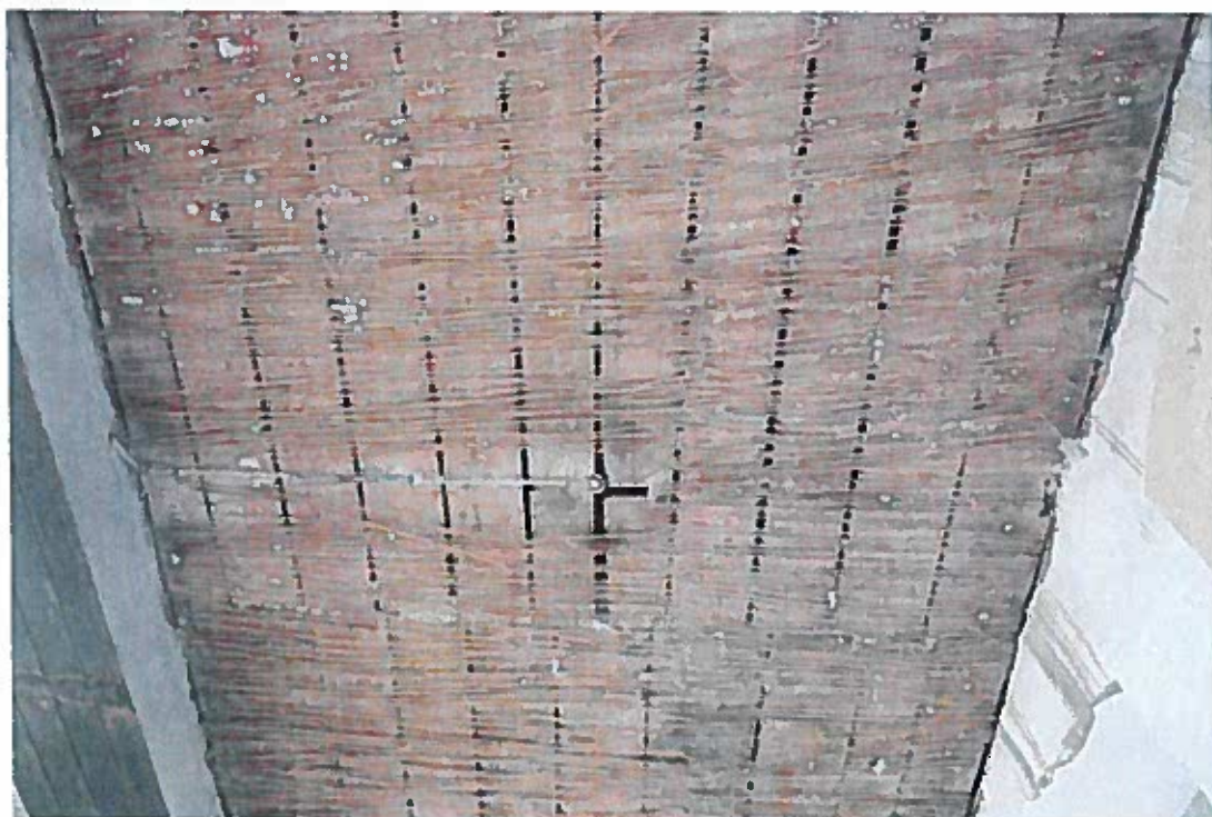
Foto. 13 Místnost A.N03.001 – detail obnažené stropní rákosové rohože po odstranění veškeré omítky. Rohož vede pouze v příčném směru a je řídký, rákosové stvoly jsou tenké a polámané. Diskutabilní je rovněž stav deskového podbití, které je seschlé.
