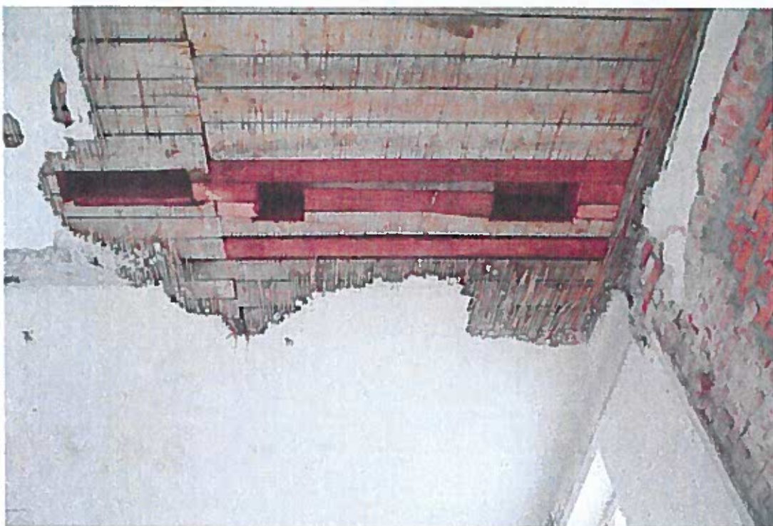
Foto. 22 Místnost B1.N03.015-014, v oblasti obnaženého stropního podhledu je dobře patrný stav rákosového podhledu. Na rozdíl od budovy A jsou rákosové rohože tvořeny silnějšími stvoly, ovšem to je jediná změna, poškození podhledů je obdobné.
