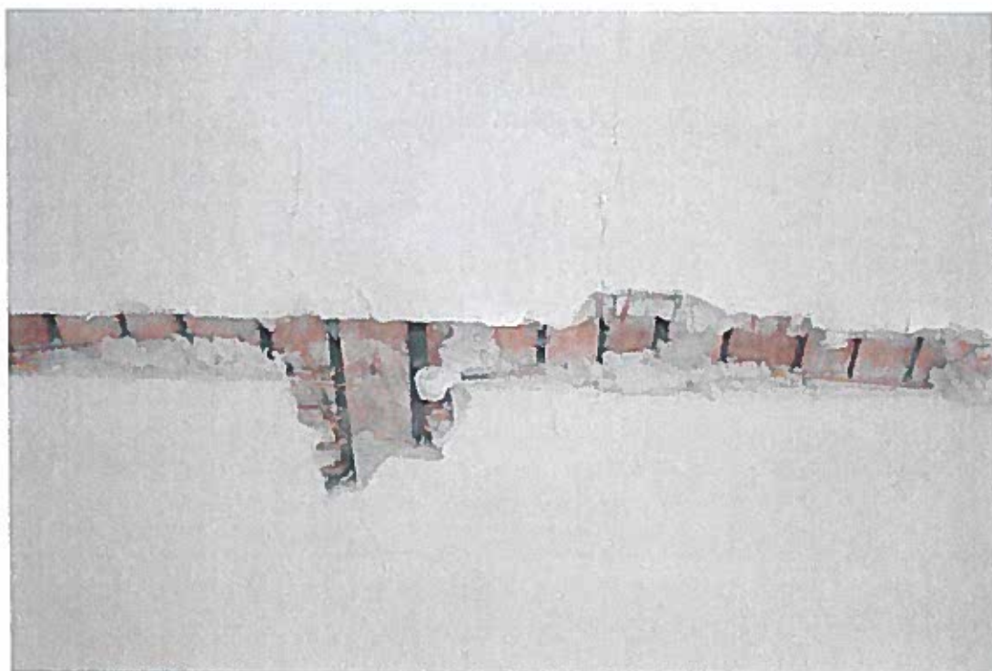
Foto. 9 Místnost A.N04.009, kromě relativně řídkého rákosu (v obou dvou směrech jsou zde zejména patrné výrazné trhliny způsobené průhybem stropu, jdoucí ve směru podbití, tedy kolmo na směr stropních trámů).
