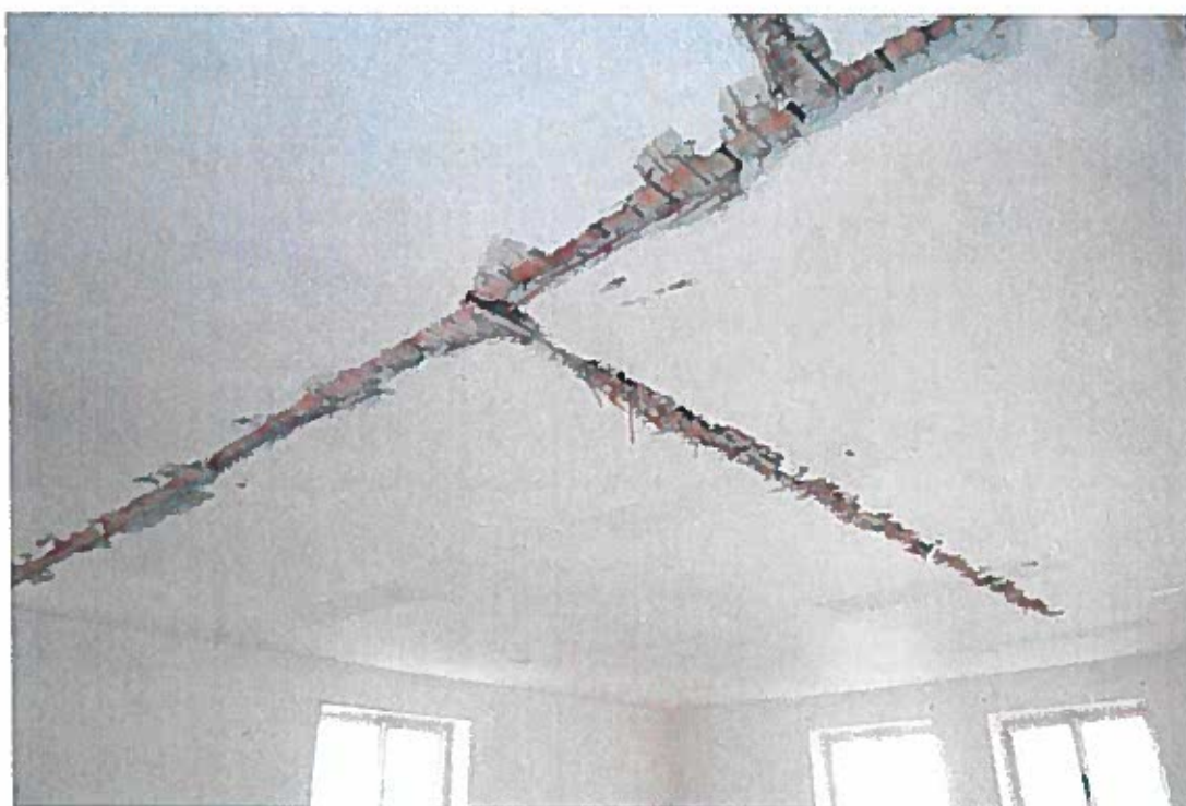
Foto. 7 Odstraněné části podhledů po vybourání příček v místnosti A.N04.011, opět výrazný průhyb celého stropu.
