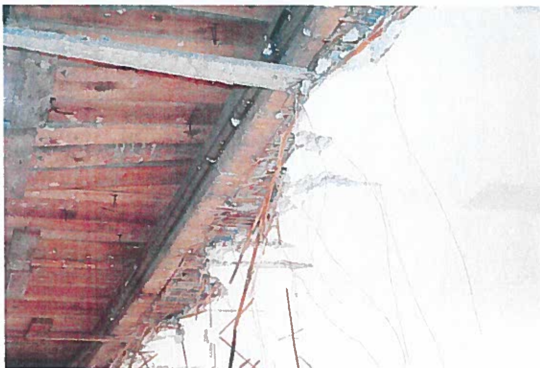
Foto. 6 Detail vybourané části podhledu z foto5, fotografováno od schodiště. V detailu je vidět, že rákos ve 4. NP je odlišný od rákosu ve 3.NP – je silnější. Souvisí to s rozdílným stářím obou podlaží.
