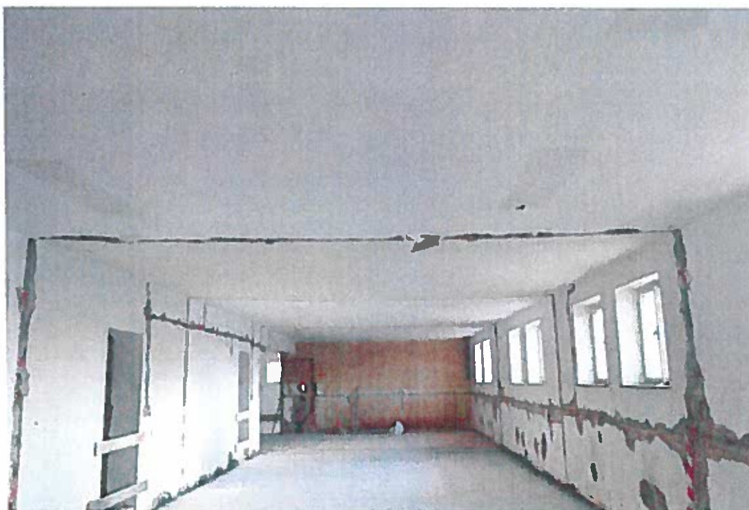
Foto. 1 Místnost A.N04.012-015, poškozená omítka po odstranění příček a současně patrné nadměrné průhyby stropů. Jedná se o dřevěné trámy a velké rozpětí, jedná se o problém celého 4. NP snad s výjimkou původní chodby.
