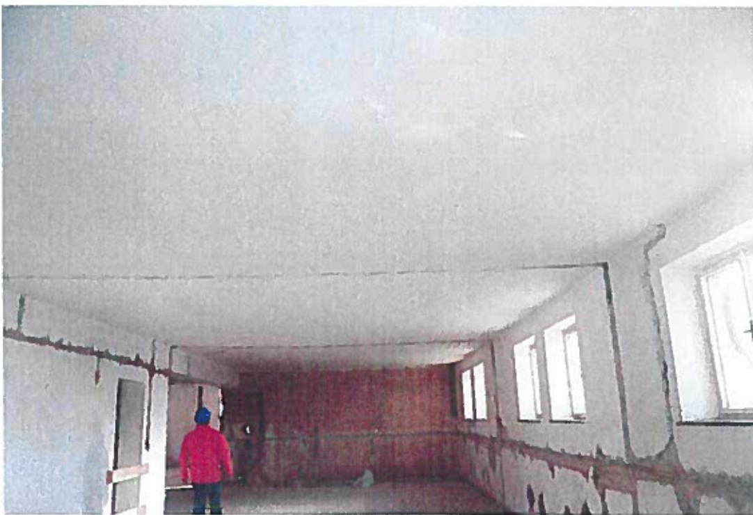
Foto. 2 Místnost A.N04.012-014, o nadměrných průhybech svědčí i způsob porušení podhledů trhlinami – trhliny jsou výrazné a jejich směr je kolmý na směr stropních trámů.
