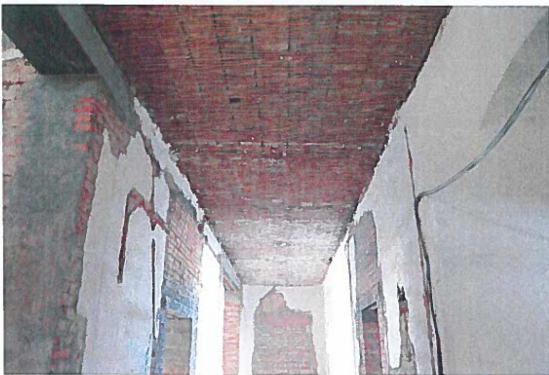
Foto. 12 Místnost A.N03.001 – chodba ve 3.NP podlaží se zcela obnaženou rákosovou rohoží. Pohled směrem k budově B1.
