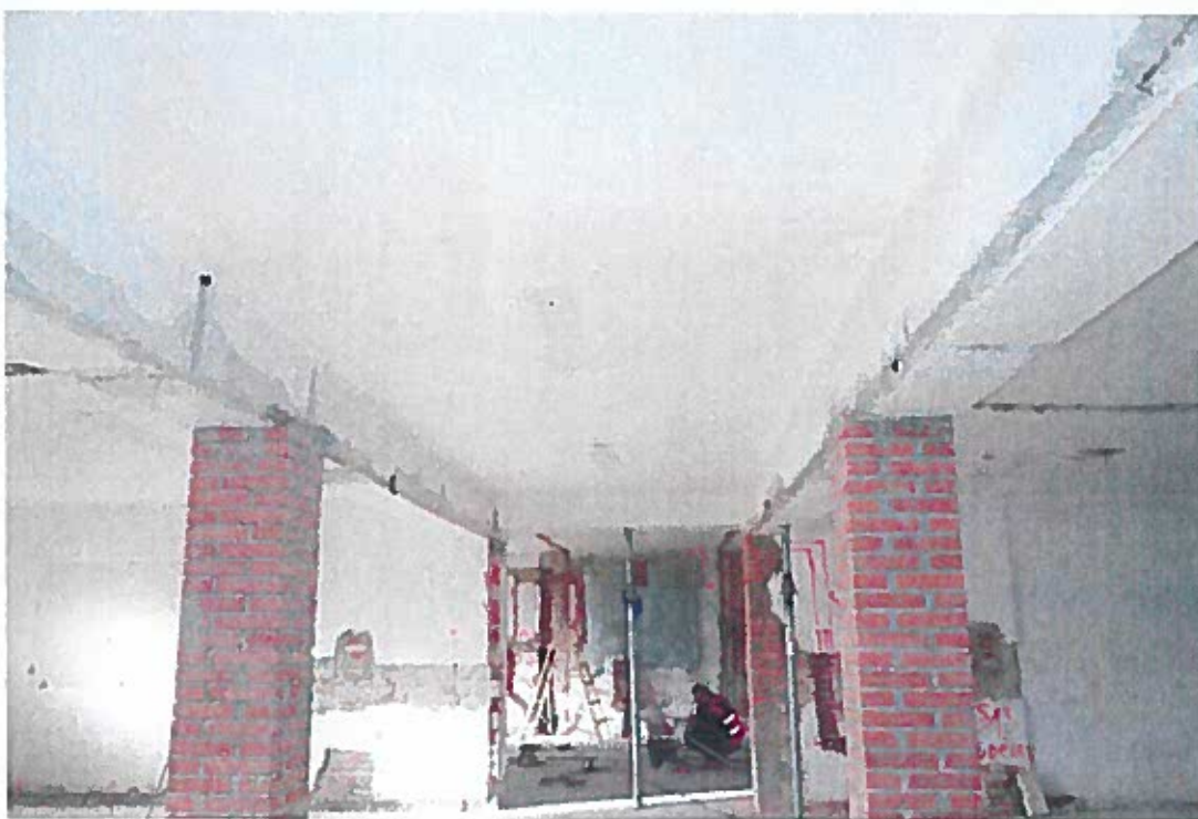
Foto. 10 Místnost A.N04.010, původní chodba ve 4. NP. Zde je poškození rákosových podhledů menší, zřejmě z důvodu menšího rozpětí a tím i průhybu stropních trámů.
