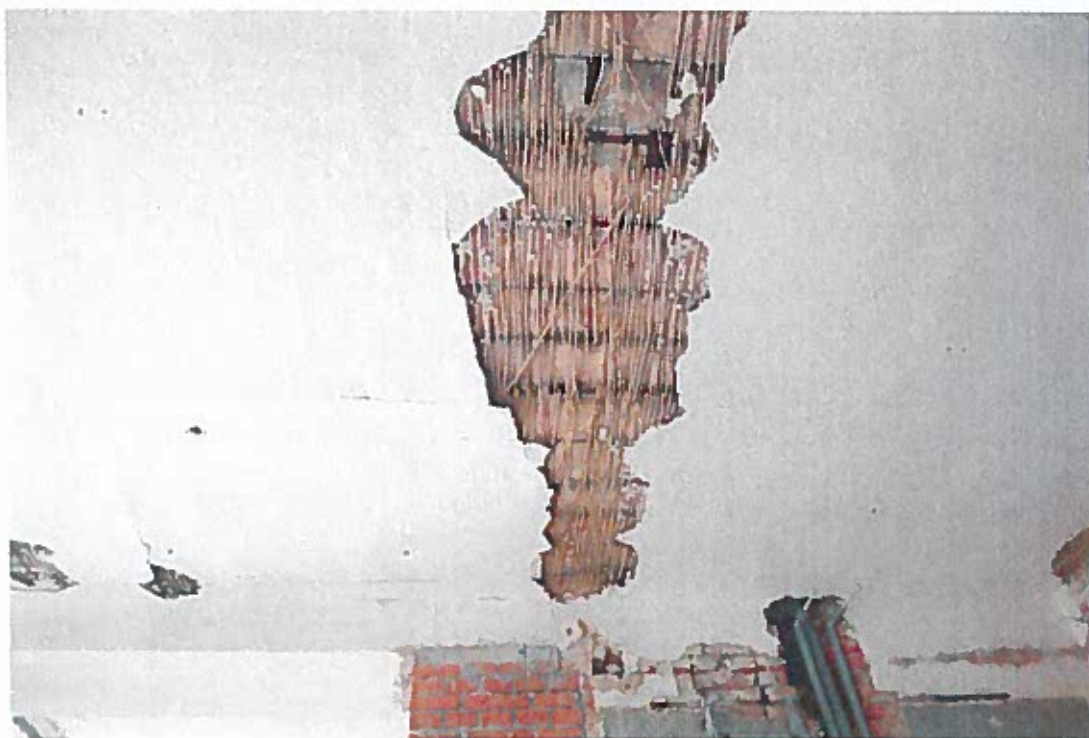
Foto. 17 Místnost A.N03.019 a 009 (vlevo) s velmi špatným stavem omítky i podhledu – platí pro místnost i pro chodbu. Ve 3.NP budovy A je tristní stav podhledů bez výjimky.
