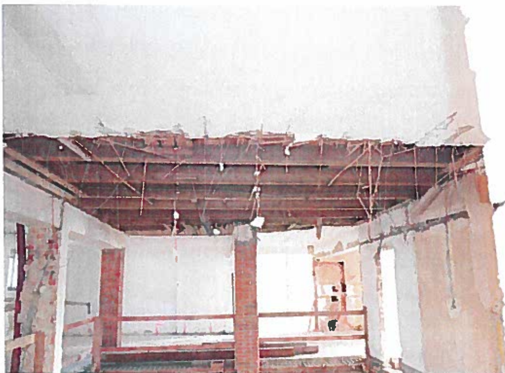
Foto. 5 Pohled na obnažené stropní trámy ve 4.NP budovy A, foceno z A.N04.026.
