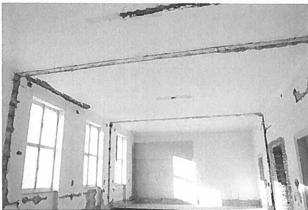
Foto. 24 Místnost B1.N03.006-007, poškozená omítka po odstranění příček. Poškození omítek od průhybu stropní konstrukce je zde o něco menší, než v budově A, což ovšem může být způsobeno odlišnou skladbou stropu. V této době (1905) se totiž hojně používaly samostatné trámy určené k vynesení podhledů, tzv. rákosníky. Ověření skladby stropu nebylo součástí hodnocení stavu podhledů.
